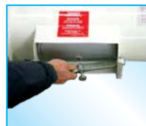
7 Inspekční otvor pod vsypem
